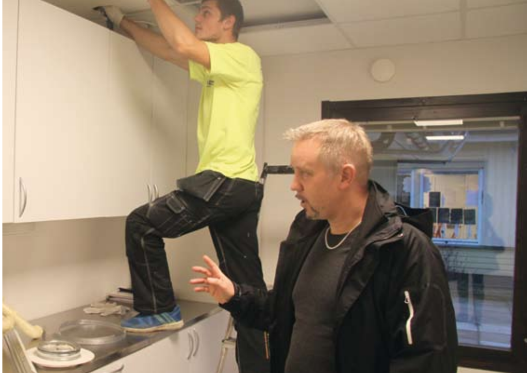
Mats Karlsson från Upplands-Brohus på plats i den snart färdigrenoverade avdelningen på Brunna Förskola. Foto: Lena Malmsten-Bäverstam.
