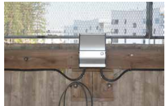
Vi har installerat nya motorvärmare i garaget på Bergvägen. Foto: Tobias Pettersson
